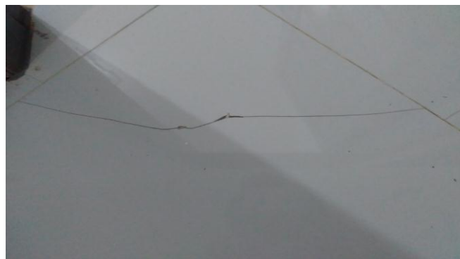
Gambar 2. Retak pada Lantai
