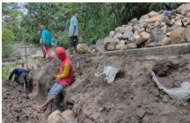
Gambar 1. Pekerjaan Talud di Desa Tladan
