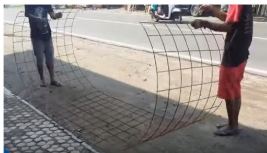
Gambar 2. Persiapan bingkai kolam
