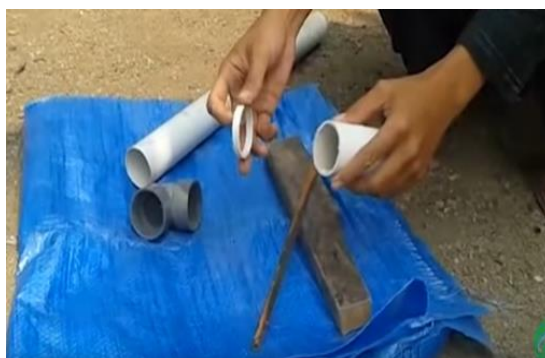
Gambar 3. Pemasangan terpal dan pembuatan saluran buang
